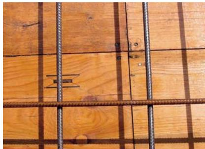
**Abb. 39: Beispiel für gleichmässige Schalhautfugen an Decke und Wänden, Feinmörtelaustritt im Übergang (Arbeitsfuge) Decke/Wand**
