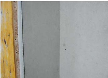
**Abb. 38: Beispiel Schalhautfugen einer Tafelschalung**
