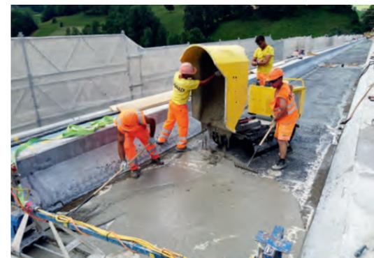
Aufbringen der Ductal<sup>®</sup>-Schicht auf dem Boden des Trogs.
