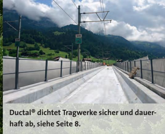
Ductal® dichtet Tragwerke sicher und dauerhaft ab, siehe Seite 8.
