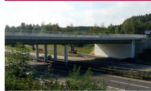
Der Beton der Widerlager und Mittelpfeiler der Überführung Grafstal (Gemeinde Lindau) über die Autobahn A1 wies Schädigungen durch eingedrungene Chloride auf.
