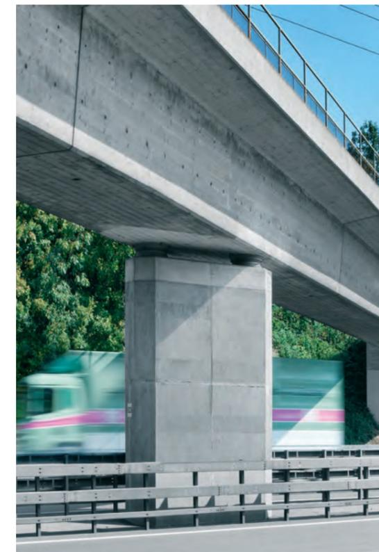
Ummantlung eines Brückenpfeilers mit 40 mm starken Elementen aus UHFB zum Schutz gegen Chloridangriffe (Ausführung: 2010).
