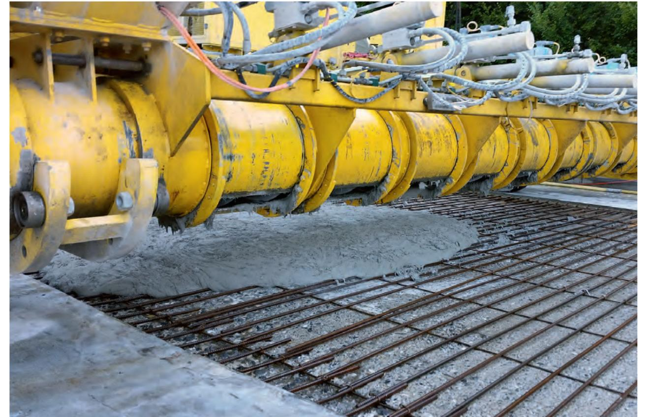
Maschieller Einbau einer Verstärkungsschicht aus Ductal® mit einem Deckenfertiger (Viaducs de Chillon).
