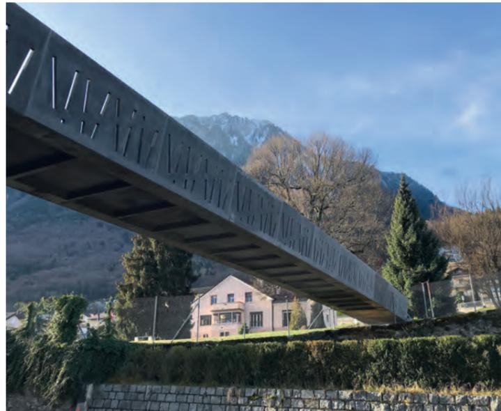
Ein eindrückliches Beispiel für die neuartigen Anwendungen aus vorgefertigtem Ductal® stellt die Fussgängerpasserelle in Le Bouveret dar. Der als Trogbücke konzipierte Übergang wurde in einem Stück und in kürzester Zeit ohne weitere Verkehrsbehinderung versetzt. Die mit Ductal® möglichen, sehr schlanken Bauteilabmessungen verleihen der Fussgängerbrücke eine grosse optische Leichtigkeit.
